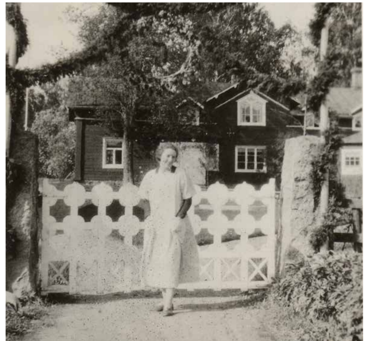
Päärakennukselle johtava vanha portti, 1926
