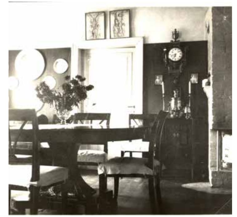
Päärakennus ruokasali (nykyinen keittiö ruokailutila) 1924
